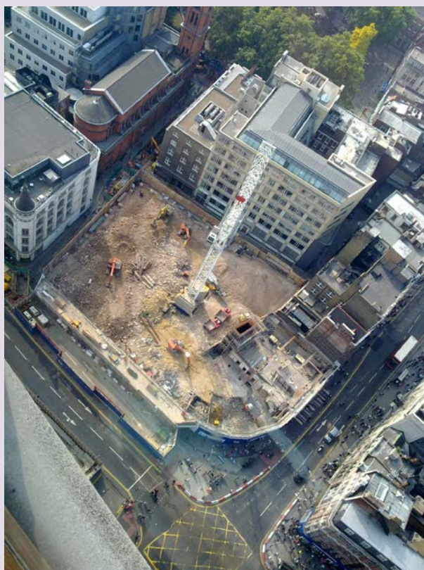
Tottenham Court Road Crossrail byggarbetsplats, England.
